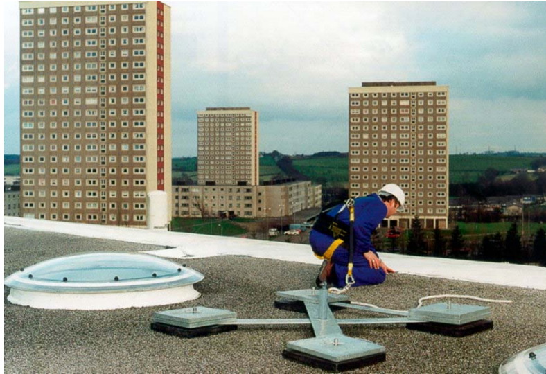
Bild 16: Durch Eigengewicht gehaltene Anschlagseinrichtung (z.B. Betongewichte)
