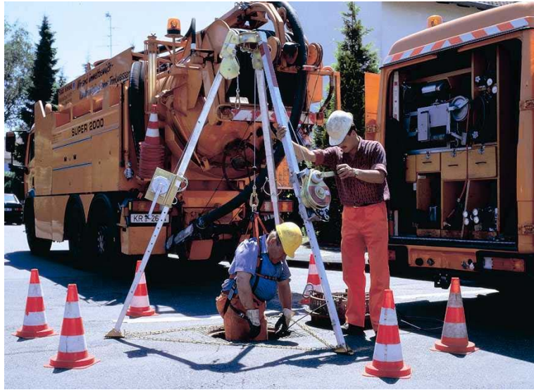
Bild 17: Rettung aus einem Schacht mittels Hörsicherungsgerät mit integrierter Rettungshubeinrichtung und transportabler Anschlageneinrichtung (Dreibein)
